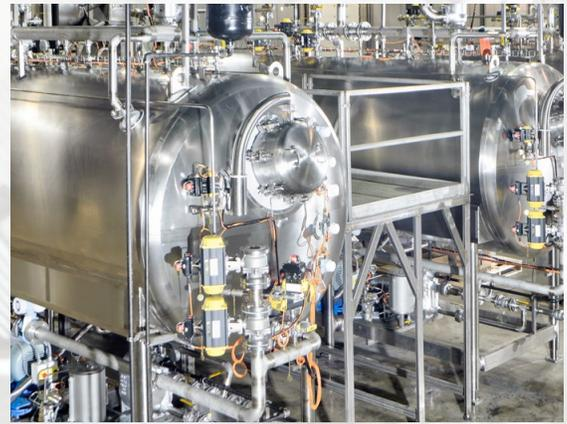
*BSL-4 Effluent Decontamination System.*
